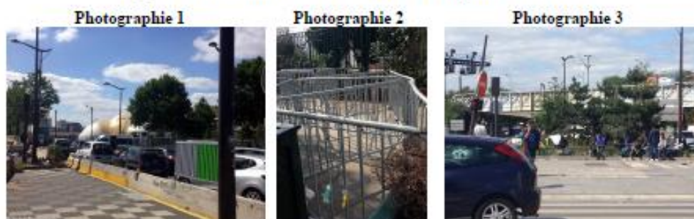
Figure 2. Une entrée contrôlée et soumise à un parcours balisé
