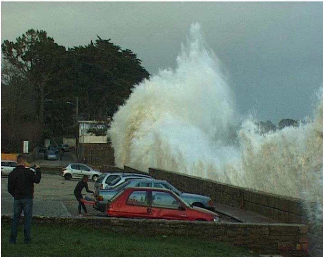
Photo 6. Phénomène de franchissement par « paquets de mer » amplifié par la présence d'un perré. Le 10 mars 2008 sur la plage du Trez Hir à Plougonvelin (Cliché : R. Gladu).
