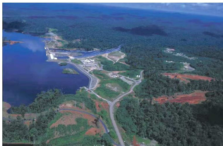
Barrage de Petit-saut en Guyane. Wikimedia
