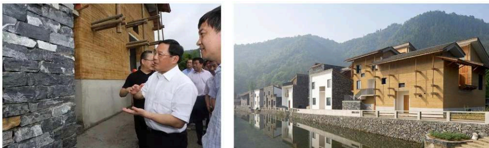
Figure 12. Matériaux locaux (marbre gris de Hangzhou, mur en terre battue et mur en pisé) dans les nouveaux bâtiments de Wencun
