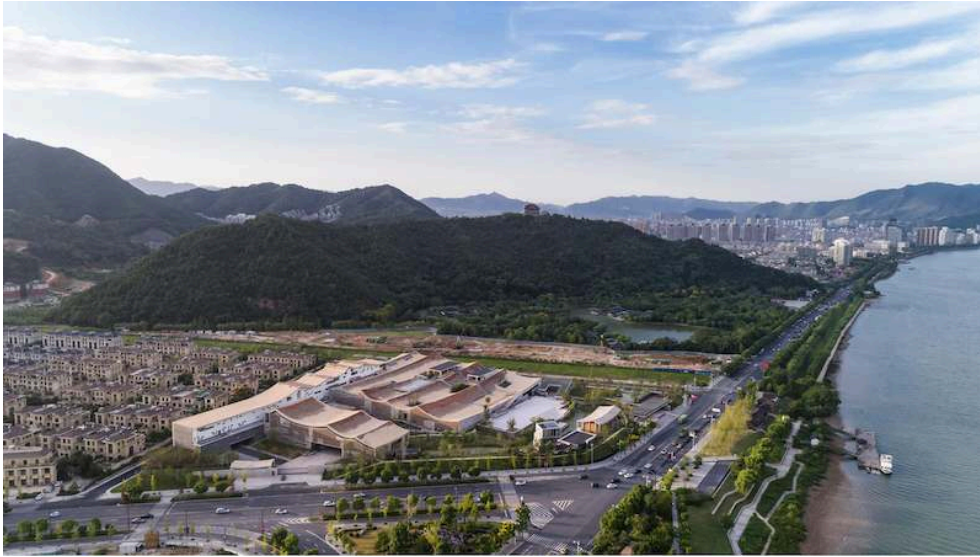
Figure 7. Vue aérienne du Complexe culturel de Fuchun
