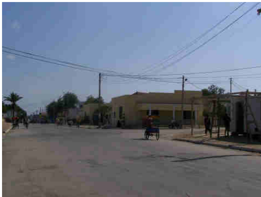
Figure 6b. « Kilimbazaha » dans le boulevard Delaveau.
